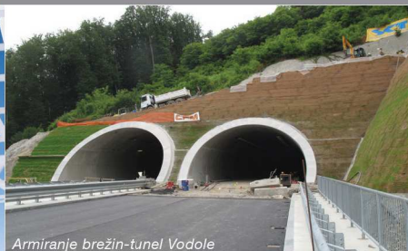
Armiranje brežin-tunel Vodole
