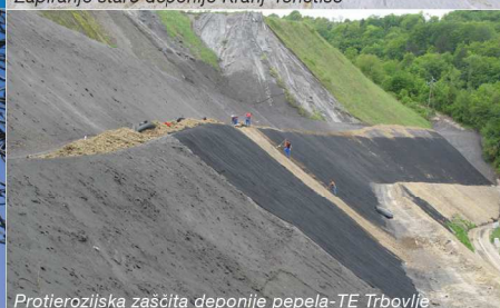
Protierozijska zaščita deponije pepela-TE Trbovlje
