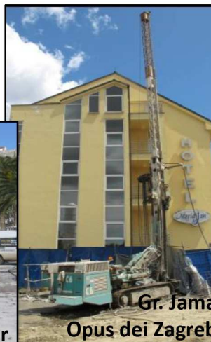
Temeljenje s CFA piloti Notranje gorice
